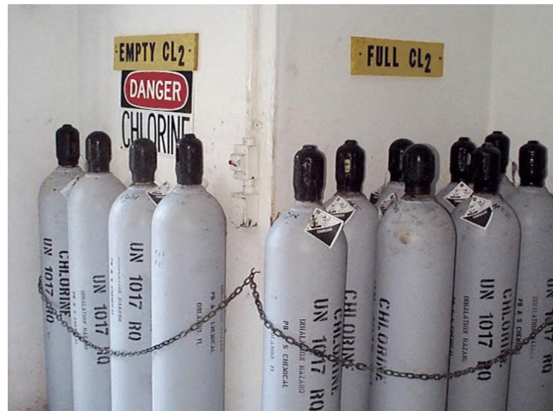
Зураг 2. Баллонтой хлоруудыг байрлуулсан байдал
