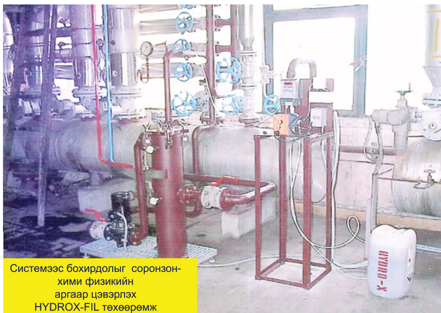
Системээс бохирдолыг соронзон-хими физикийн аргаар цэвэрлэх төхөөрөмж HYDROX-FIL
