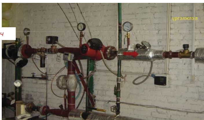
Дулааны шугам, халаалтын систем, угаахын зэрэгцээ дулааны узелийг мөн угаана, Хог шүүгчүүдийг тогтмол цэвэрлэж байх хэрэгтэй.
