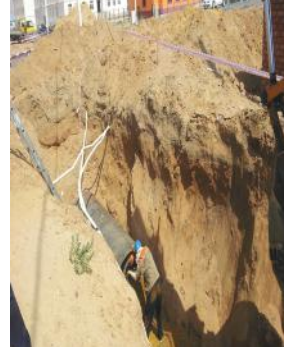
14м өргөнтэй авто зам сүвлэж дулааны шугам угсралтын ажил гүйцэтгэж байгаа
