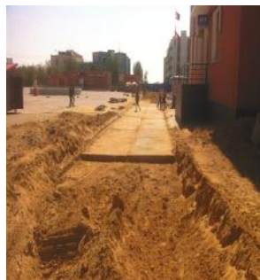
Шугам угсралтын ажлын дараа нөхөн сэргээлт хийж буй байдал
