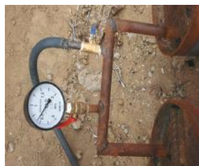
Усан шахалт хийж дулааны шугам шалгаж байгаа нь
