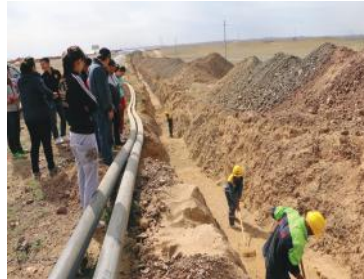
Цэвэр усны шугамын элсэн дэвсгэр
