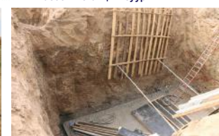
Насосны станцын суурь
