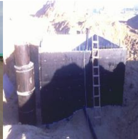
Бохирын насос станцын 6х6х7h бүрэн цутгамал барилга 7м түвшинд цутгасан байдал
