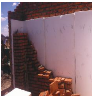
Ус түгээх байрны барилгын хана - дулаалгын хөөс 10см, 380 тоосгон хана өрж буй байдал
