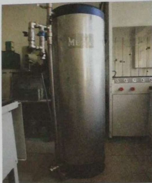
Томоохон ус хэрэглэгчид /цагт 3-5шоометр/ тавигдах АПТ маркийн шүүлтүүр
