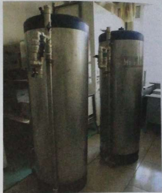
Томоохон ус хэрэглэгчид /цагт 3-5шоометр/ тавигдах АПТ маркийн шүүлтүүр
